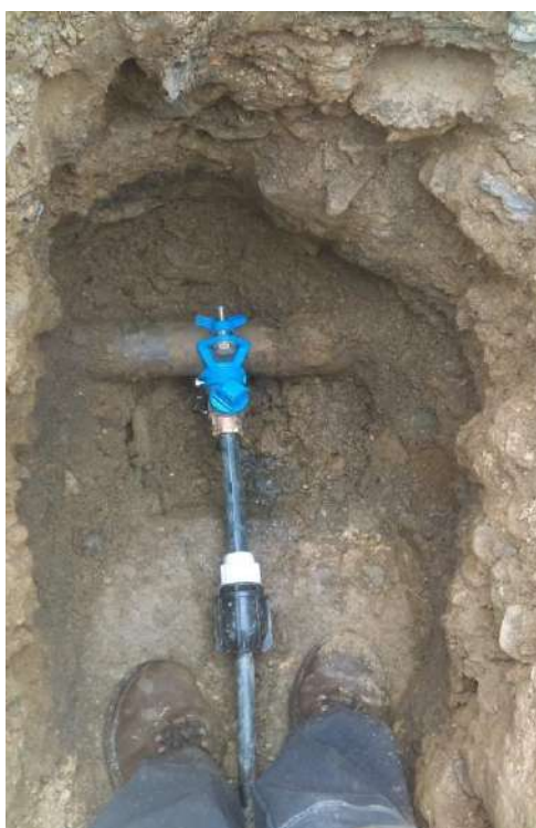
Prise en charge sur conduite acier à Ste Féréole (avant réparation)
