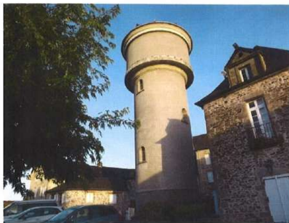
Le réservoir sur tour de Ste Féréole
