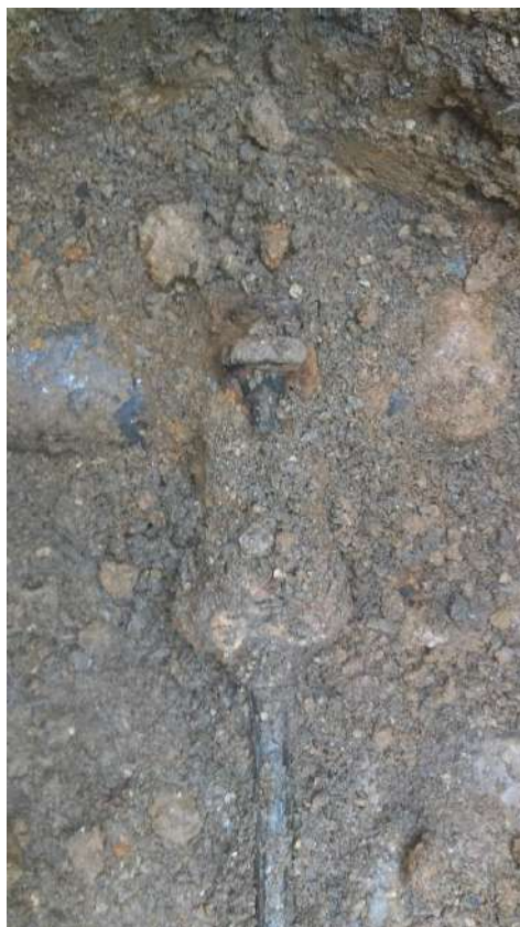
Prise en charge sur conduite acier à Ste Féréole (avant réparation)
