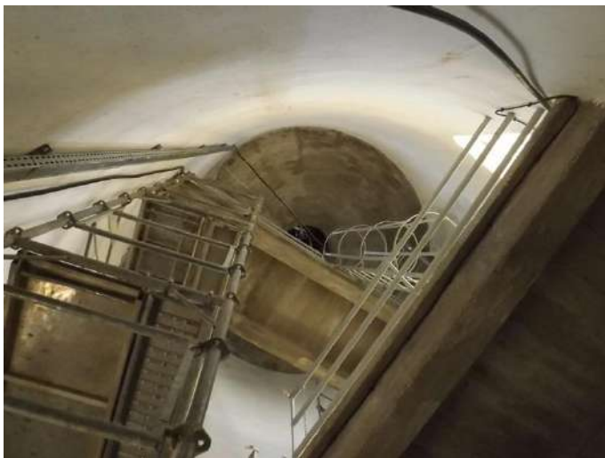
L'intérieur du réservoir de Ste Féréole (photo prise pendant les travaux de réhabilitation réalisés en 2014)
