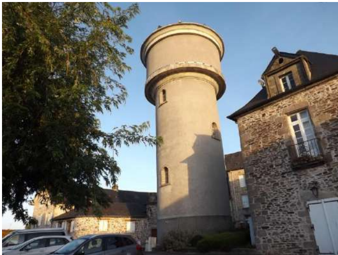
Le réservoir sur tour de Ste Féréole (200 m3)
